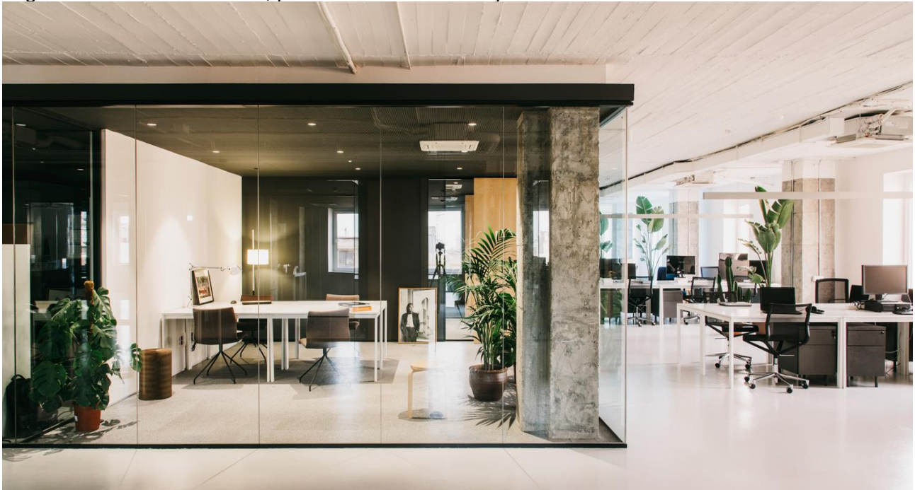
Figura 4. Divisórias de vidro, possibilitando a iluminação natural
