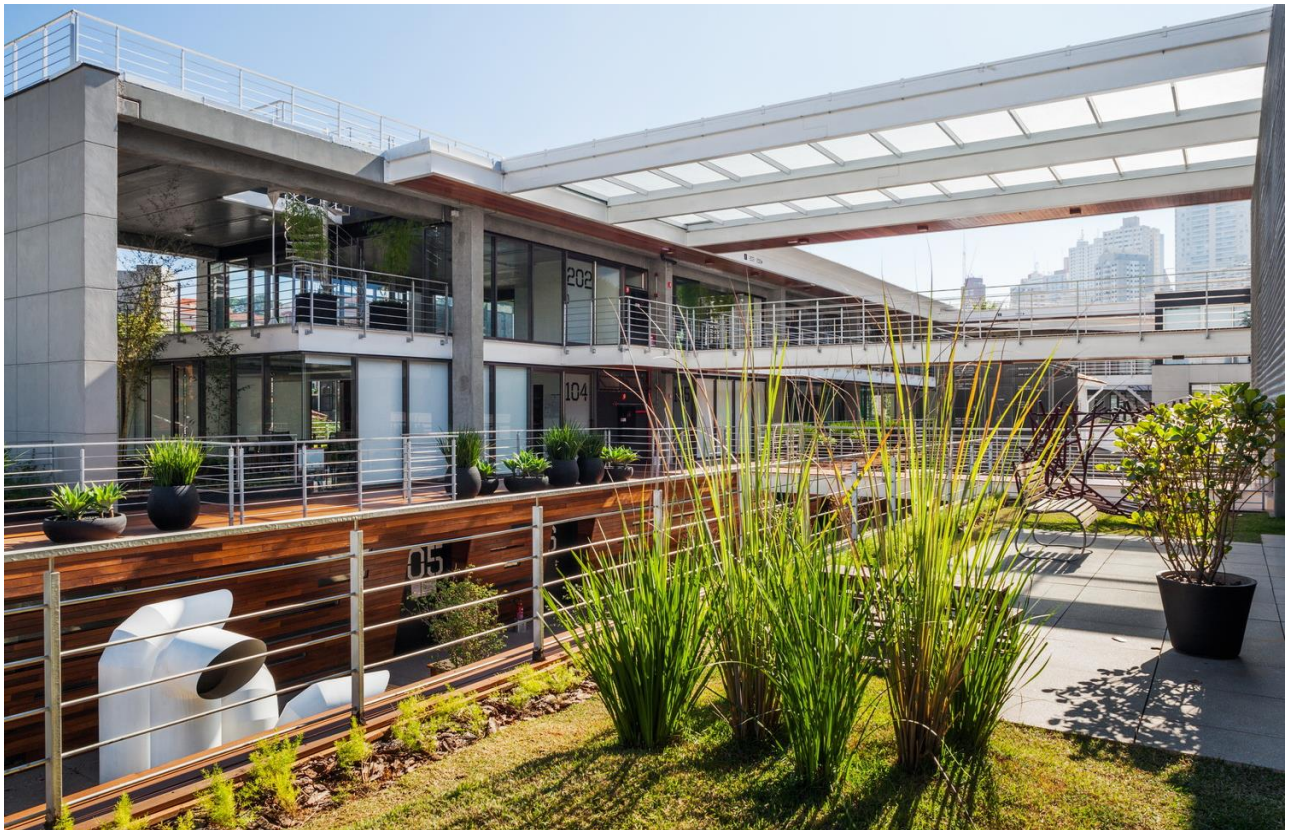
Figura 9. Estruturas de concreto pré-moldado aparente
