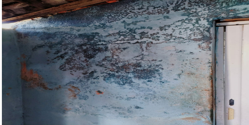
Figura 9: Umidade por precipitação. Fonte: Criação do autor (produzido em 2021).
