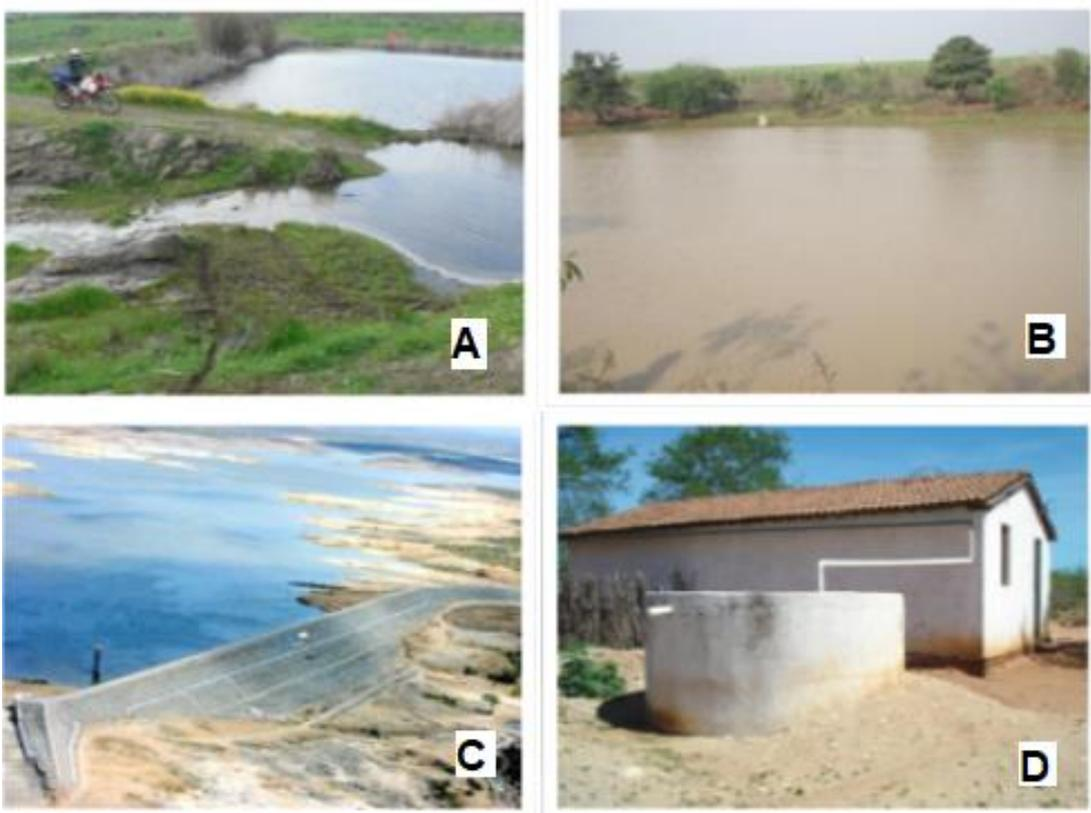
**Figura 18:** Tipos de sistemas de Captação e Armazenamento de Água de Chuva: (A) barreiros, (B) açudes, (C) barragem e (D) cisterna.
