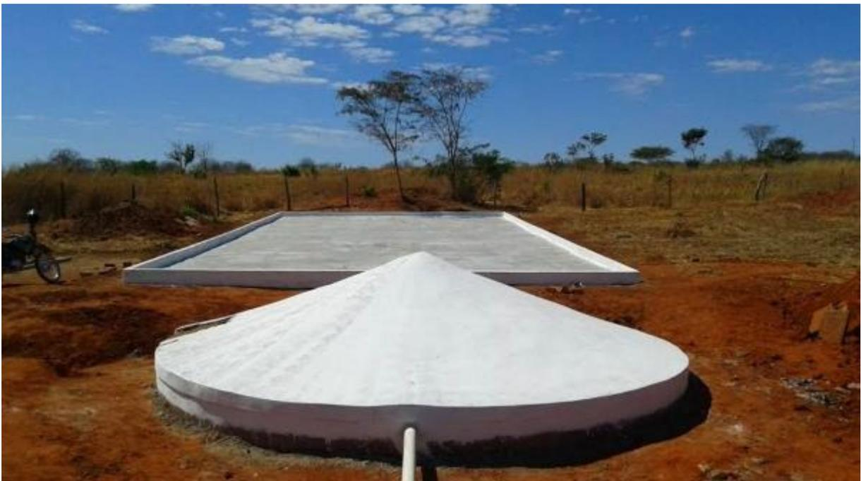
**Figura 9:** Cisterna calçadão construída no semiárido da Bahia.
