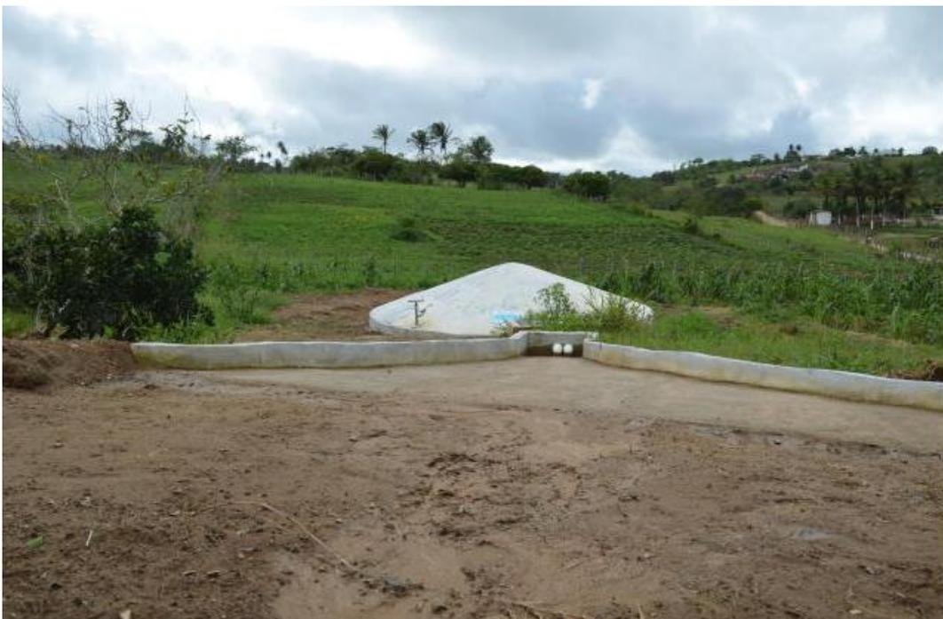
**Figura 8:** Cisterna enxurrada construída para captação da água da chuva em estradas.
