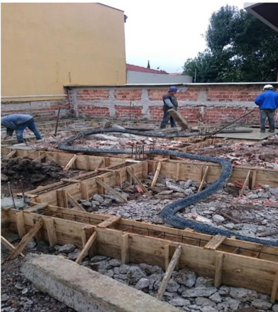
Foto 9: Preparação da concretagem.
