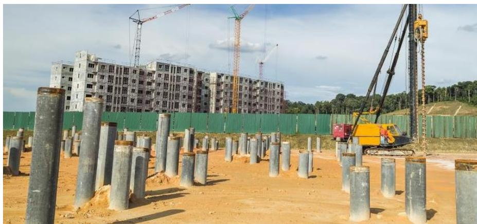
**Figura 2: Estacas de concreto**
