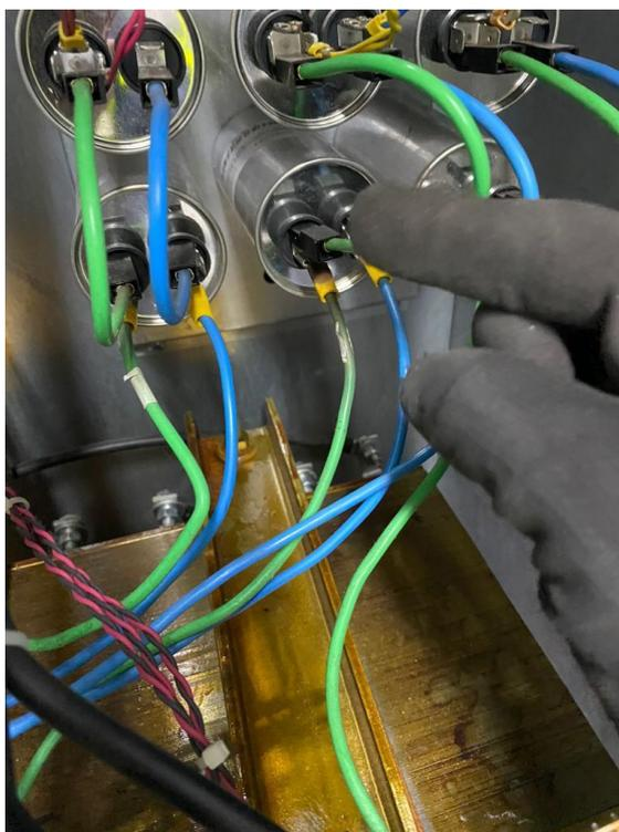
Figura 23 – Verificação da fixação das conexões durante inspeção sensítiva
