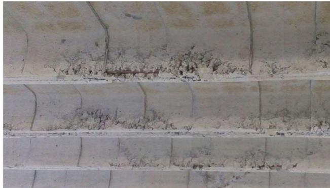
Figura 7 – Nichos de concretagem em estruturas de concreto (Votorantim Cimentos, 2016).
