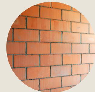
Figura 54- Parede de alvenaria cerâmica.
