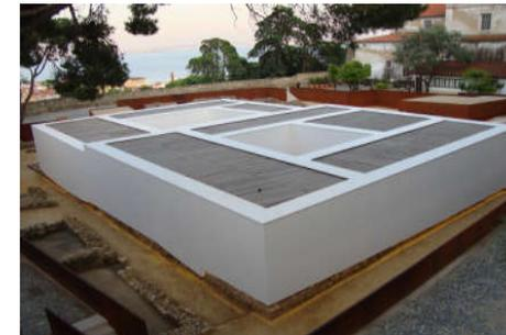
Figura 45: Cobertura de policarbonato e ripas de madeira
