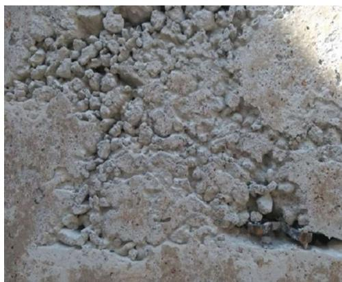
2. Realizar a remoção de todo o concreto degradado da região, cuidando para que as armaduras não sejam afetadas. Essa etapa é importante para garantia da adequada aderência entre material de recuperação e estrutura existente, contribuindo para a eficiência do tratamento.
