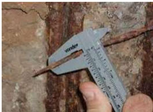
6. Constatando que essa perda foi igual ou superior a 15% da área da seção transversal da barra, efetuar o reforço ou substituição da armadura.
