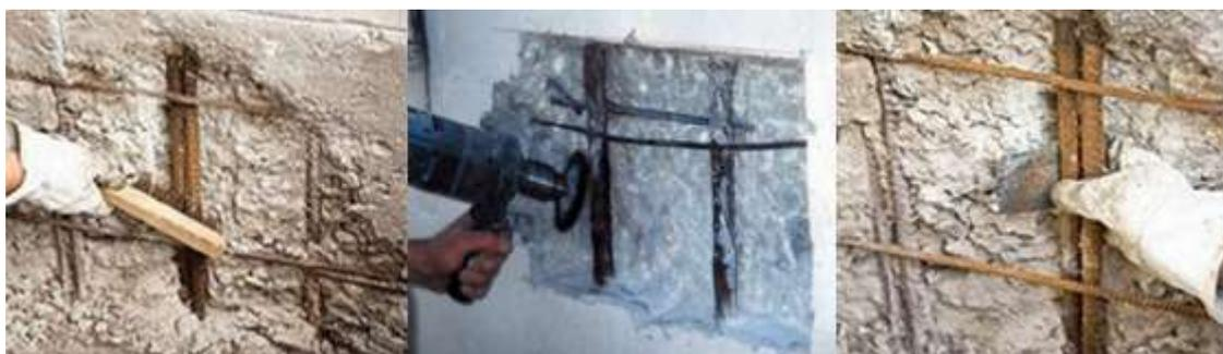
4. O profissional responsável deverá conferir se toda a oxidação foi removida e comprovar se não houve perda superior a 15% da área de seção da barra de aço. Caso haja essa perda, deverá ser realizado o procedimento indicado na FICHA 07 "Corrosão generalizada com perda de seção da armadura".
