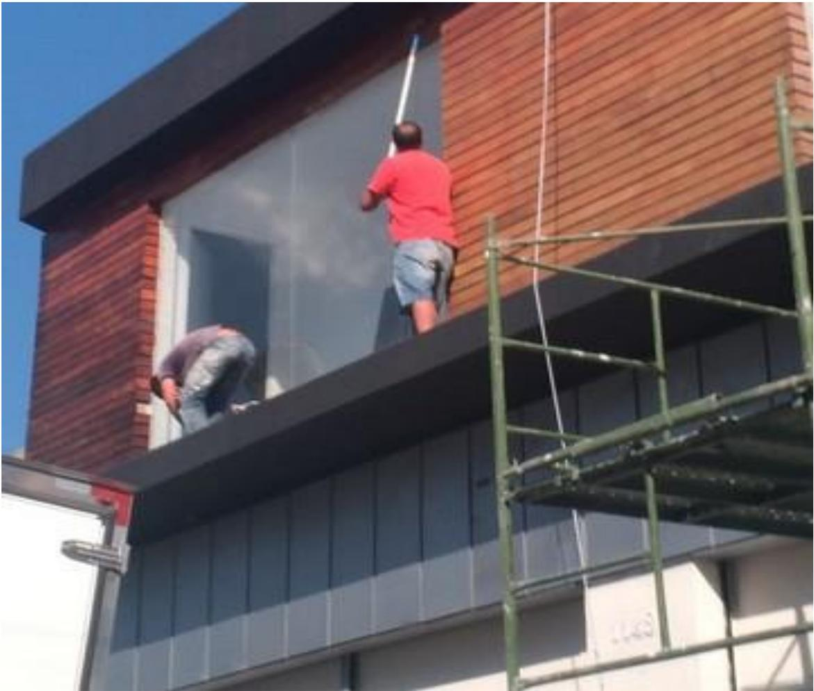
**Figura 7** - Trabalho em altura sem proteção
