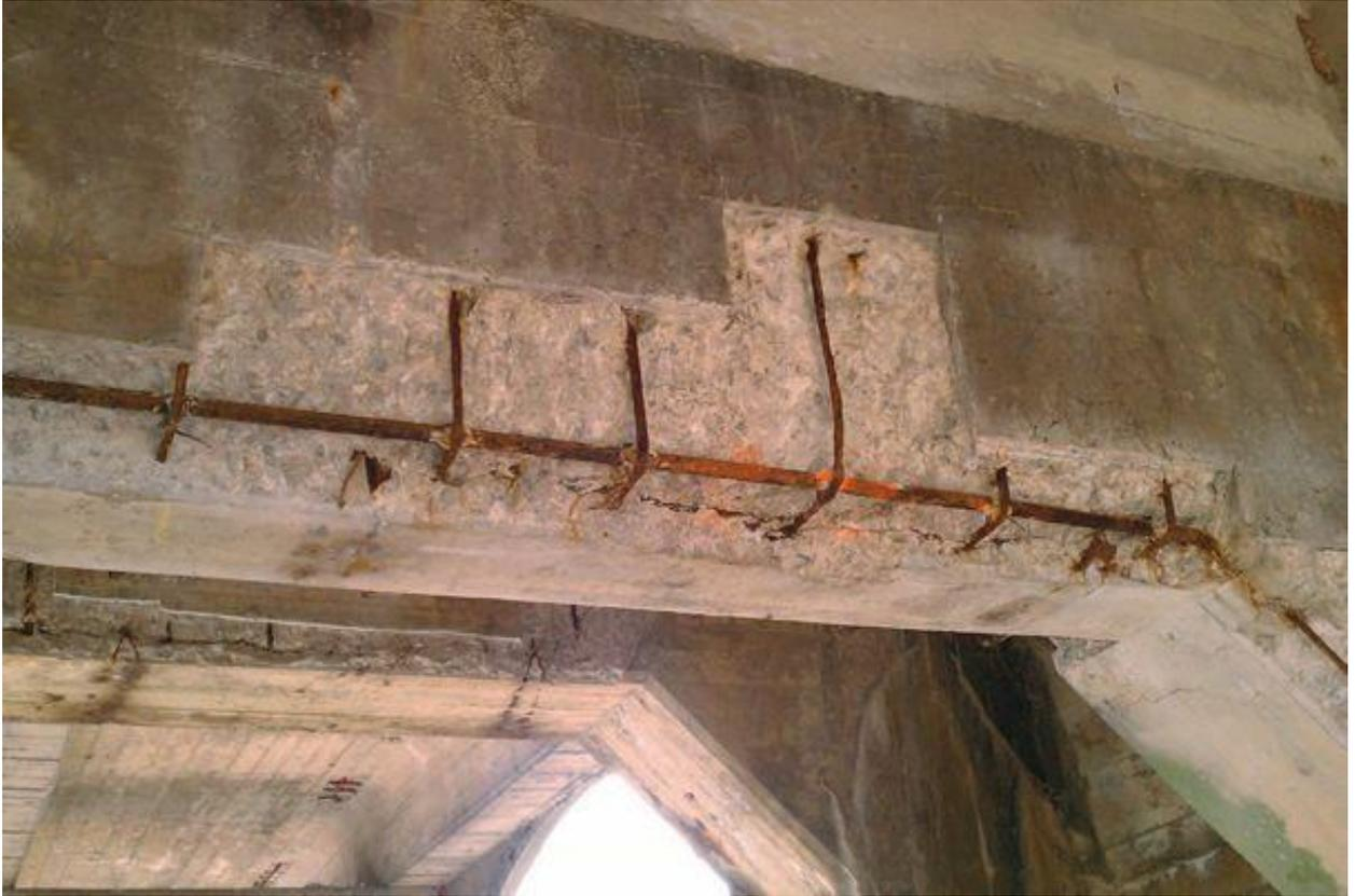
**Figura 8** - Estrutura corroída
