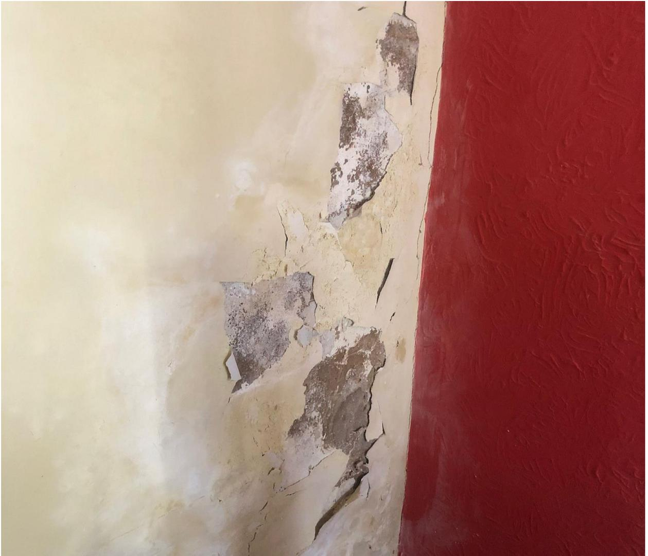
**Figura 3** - Infiltração por capilaridade em residência
