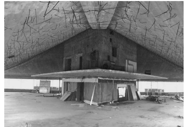
Imagem 36 - Wellness Sky em construção, laje de concreto, Triângulo central. Fonte: wikiarquitectura
