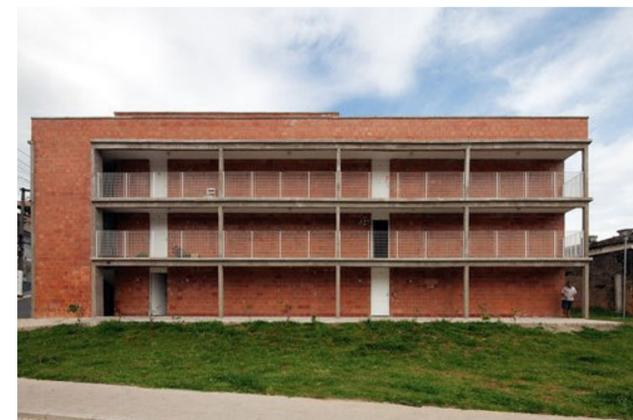
Para o conforto térmico foram utilizados brises móveis, visto que a maior parte dos quartos ficaram voltados para as fachadas leste e oeste. Na tipologia 3, as janelas das cozinhas e salas são recuadas para que o sol não incida diretamente nos ambientes, já que esses blocos estão virados para as fachadas norte e sul (ARCHDAILY, 2021).
