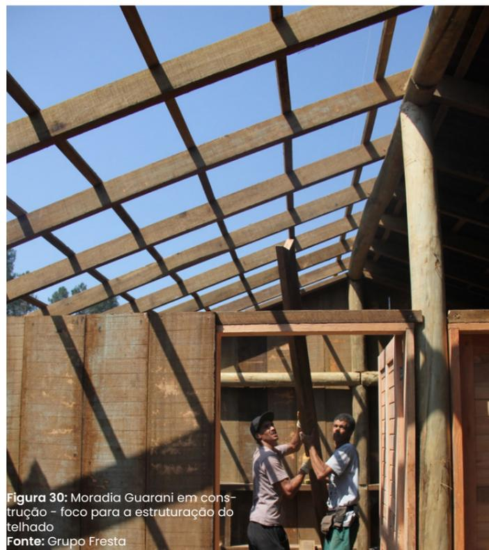
Figura 30: Moradia Guarani em construção - foco para a estruturação do telhado.
