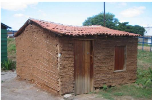
Figura 21: Casa construída com a técnica Pau a Pique
