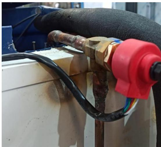
**Figura 12:** Resfriador de água com válvula eletrônica. (Fonte: O AUTOR, 2021).
