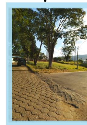
Na área para implantação da Praça do Peregrino é inexistente passeios, e a área no entorno os passeios encontram-se abandonadas e desniveladas devido ao crescimento das raízes das árvores, e desprovidas de qualquer acessibilidade nas esquinas.
