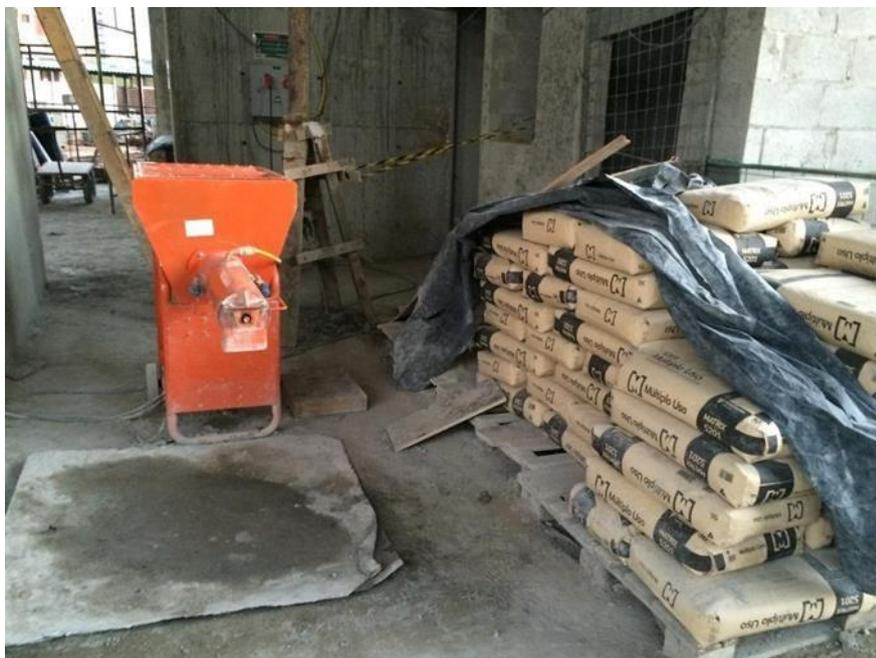
Figura 1. Argamassa ensacada com argamassadeira ao lado dela
