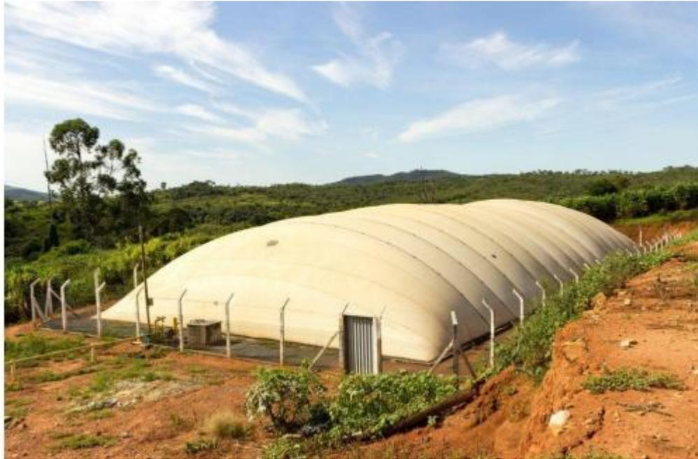
Figura 4. Biodigestor anaeróbico de modelo canadense
