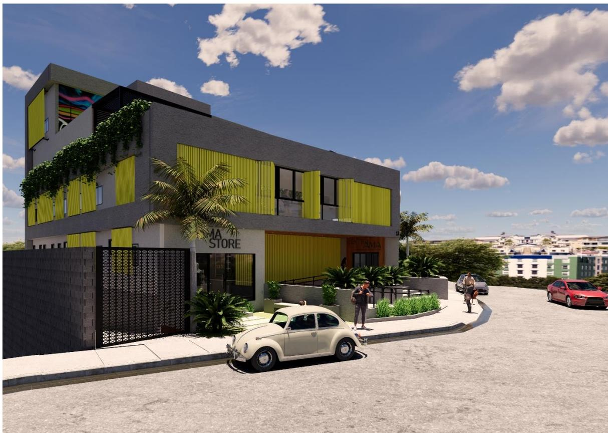
Na fachada oeste foi usado brises verticais fixos em ACM pintados na cor amarela, na intenção de barrar a incidência da radiação solar no segundo andar. A
