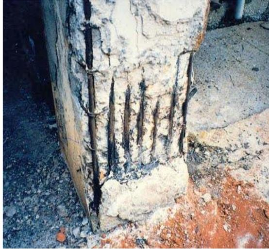
**Figura 10:** Representação de corrosão de armadura.
