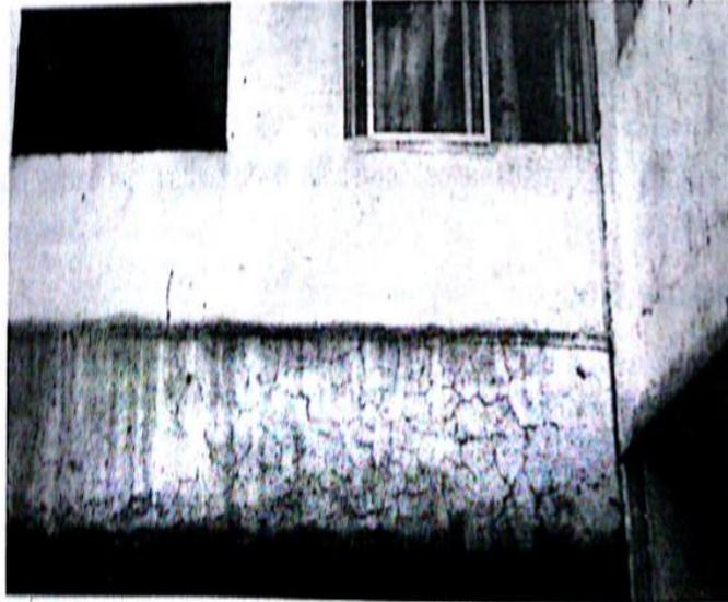
**Figura 5:** Representação de fissura por retração em viga de concreto armado.
