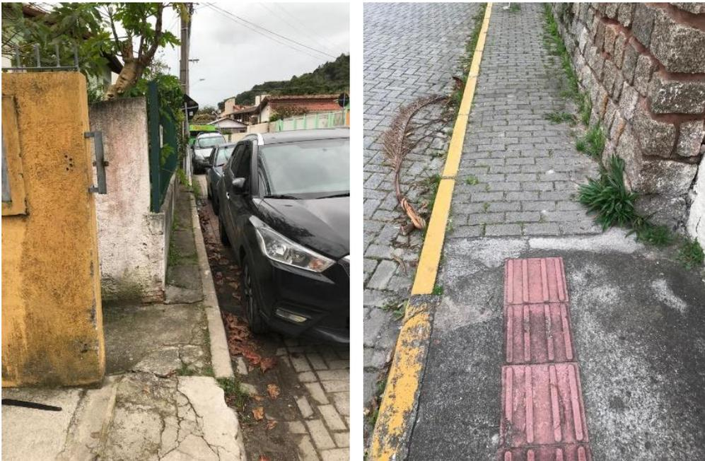
Figura 34 – Calçada estreita e falta de continuidade no piso tátil – Fonte: Autora, 2018.
