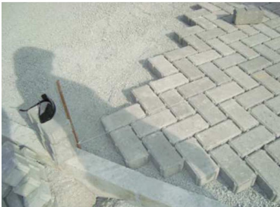
**Figura 38 - Instalação paver. Fonte: Site Soluções para Cidades.**
