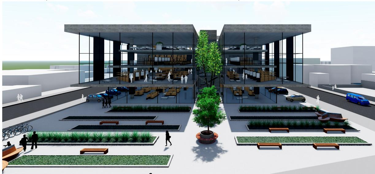
O estoque possuirá 2 pavimentos de uso, sendo o térreo destinado a materiais pesados, tubulações e conexões. O segundo concentrará materiais mais leves, como produtos elétricos. Haverá duas entradas de caminhões, uma para saída e outra para entrada, sendo separadas para não haver mistura de materiais. O setor possuirá escritório e banheiros, contando com um elevador de serviços e escada que levam aos pavimentos de loja para abastecimento.
