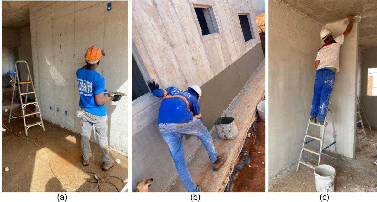
Figura 15 – Processo de acabamento. (a) estucagem das paredes; (b) impermeabilização externa; (c) aplicação de massa niveladora branca.
