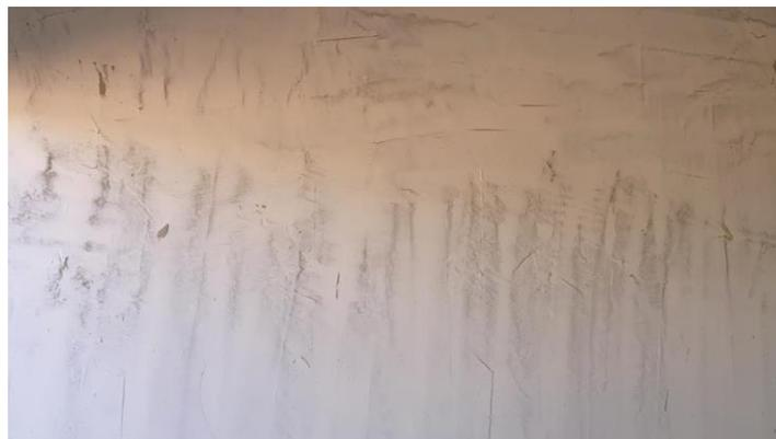
Figura 16 – Camada de massa niveladora branca aplicada de forma incorreta.
