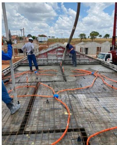
Figura 13 – Concretagem das lajes e da parede.
