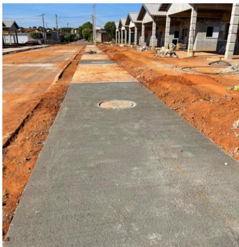
Figura 20 – Reconstrução de trechos do passeio, para liberação do serviço por relatório de qualidade.
