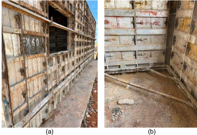
Figura 7 – Alinhadores (a) na parte externa da edificação; (b) na parte interna da edificação.
