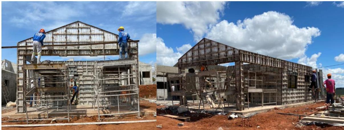
Figura 8 – Montagem e disposição das formas conforme projeto.
