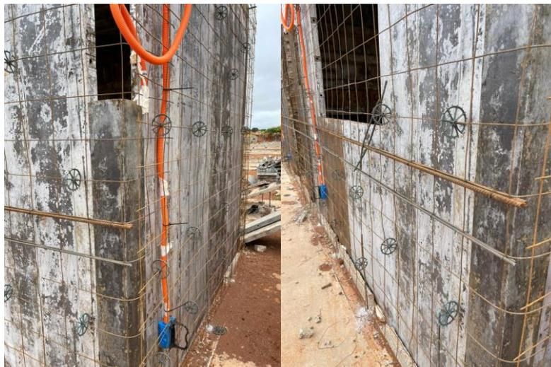
Figura 5 – Disposição dos espaçadores utilizados nos painéis.
