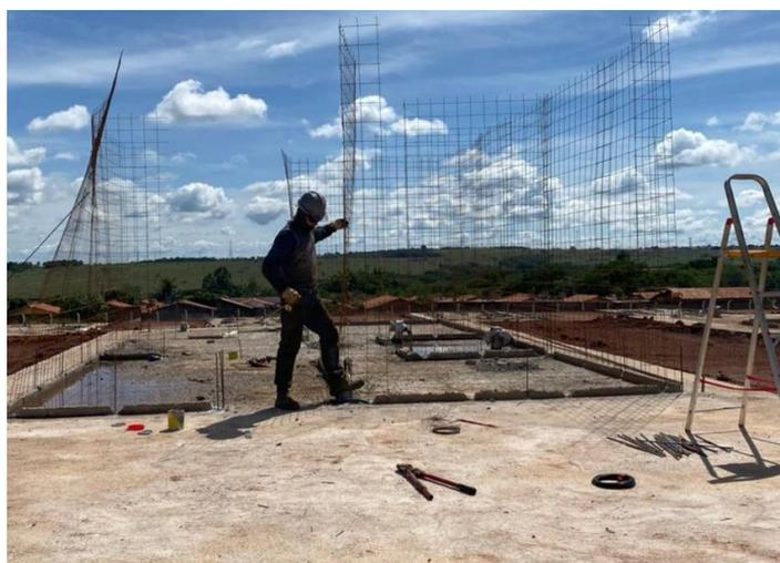
Figura 4 – Montagem e disposição das armaduras.
