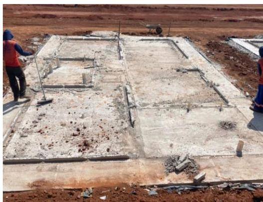
Figura 3 – Radier concretado em fase de limpeza.
