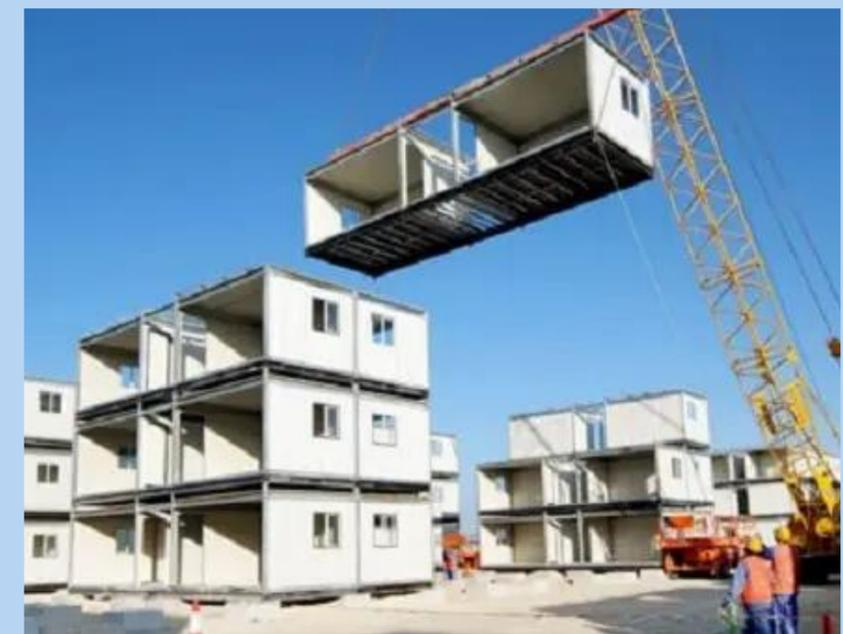
Está baseado no formato retangular acoplável, modular, que pode ser agrupado, estruturas com uso de light steel frame aliado a drywall para vedações, e também concreto e cimento para calçadas e pisos.
