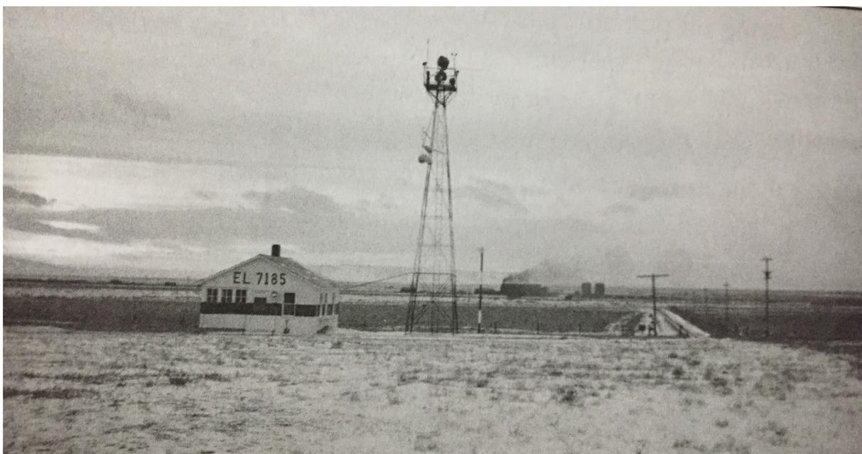
*Figura 2 - Aeroporto primitivo desconhecido (acredita-se que seja Laramie, Wyoming) fotografado no final dos anos 1920. Um dos faróis luminosos do Correio Aéreo Americano que iluminava o equivalente a cinco milhões de candelas encontra-se visível (E. B Jeppesen )*
