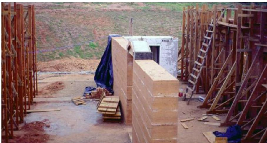
Fig. 6 - Imagens da obra da chamada Casa Gilda (Residência Gilda Barros), em que se identificam os taipais, os alicerces de pedra, estratégias de conexão quanto à estrutura de cobertura (Fotos de Fernando Minto, envolvido na construção).
