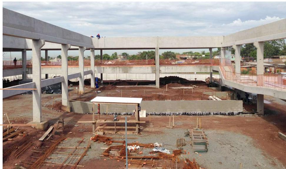
Figura 55 - Estrutura Pré Moldada - Fonte: SIAA ARQ.
