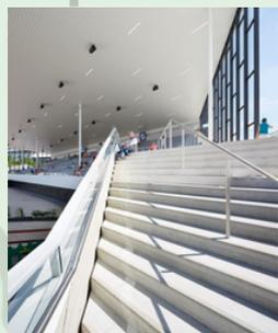
Figura 03: Degraus de concreto armado
