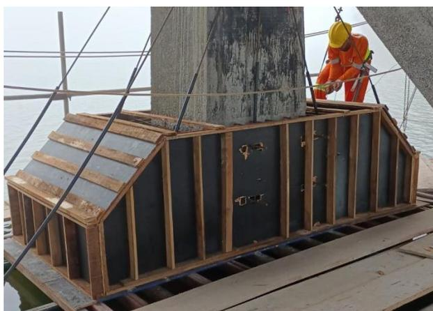
Figura 5 – Bloco de reforço da base do pilar e estaca raiz (Acervo da obra, 2022)
