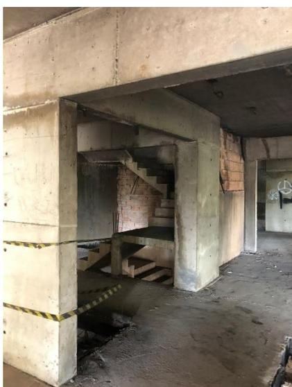
*Figura 59. Escada e fosso de elevadores na edificação existente*
