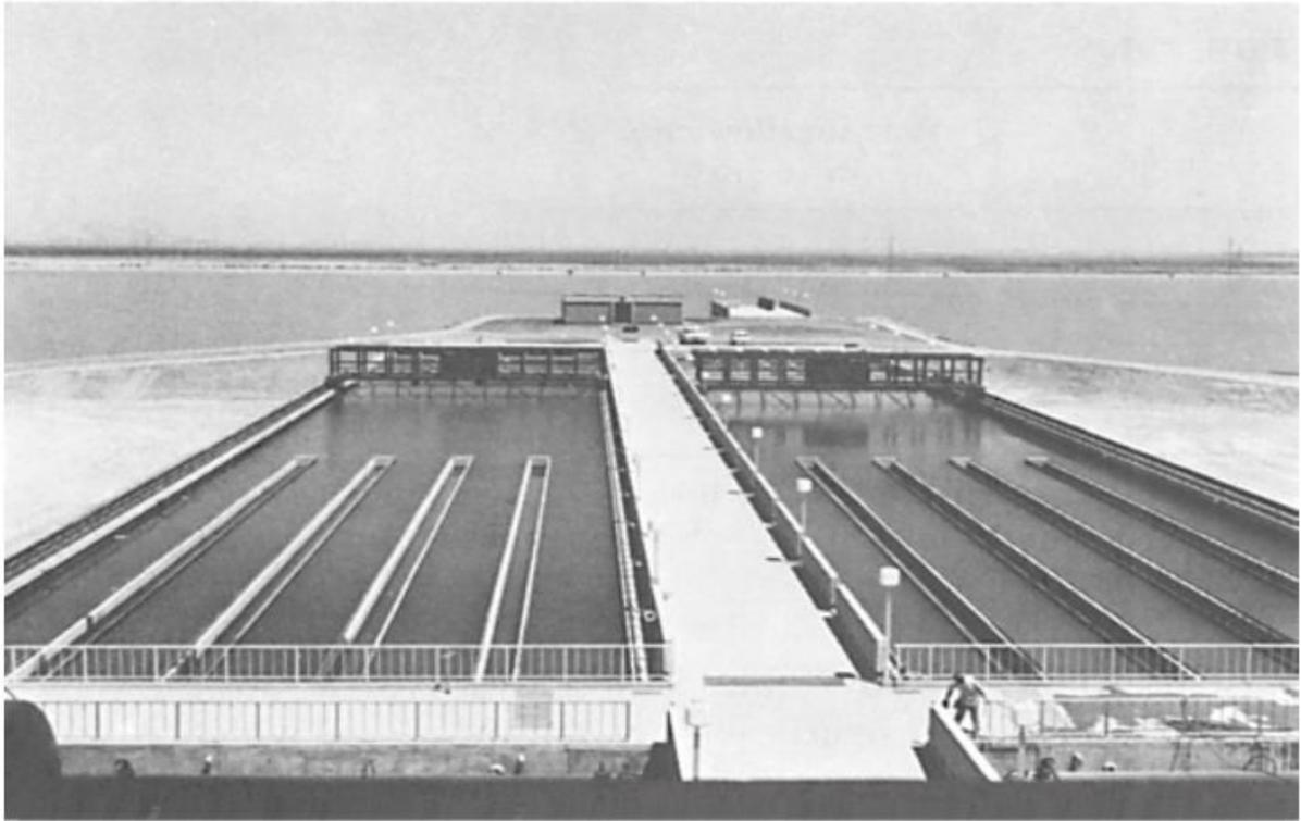
**Figura 5:** Canais de distribuição em tanques de sedimentação retangulares de fluxo horizontal.
