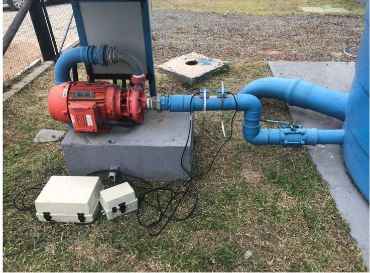
b) Senso sônico do medidor.
