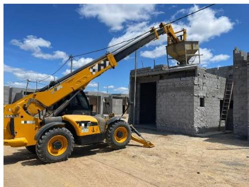
Figura 5 – manipuladora levando material conforme rota estabelecida.
