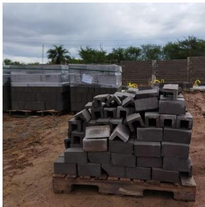
Figura 2 – blocos de refugo segregados dos blocos aprovados.
