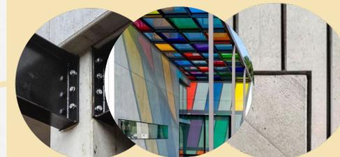
O acabamento da estrutura aparente (treliças e vigas) das escadas e passarelas serão metálicas, o guarda corpo será metálico com cabos de aço, por conta da sua leveza e personalidade, já a escada que está acoplada com o elevador será de alvenaria, a cobertura do projeto será com esquadrias e vidros coloridos.
