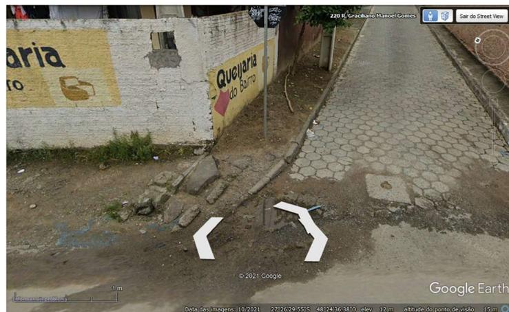
Figura 5 - Ponto C - Ausência de infraestrutura de calçada, com presença de entulhos, buracos e poças. Falta acessibilidade.
