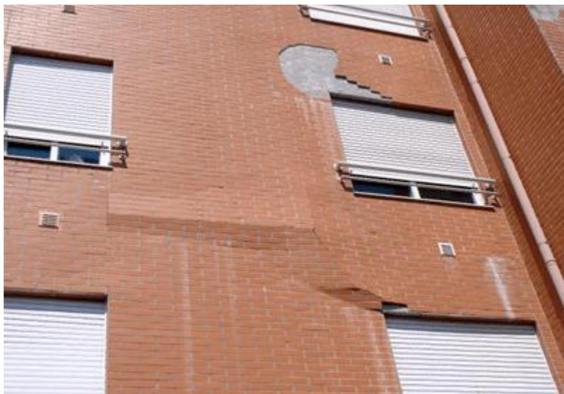
Figura 1: destacamento de placas cerâmicas
