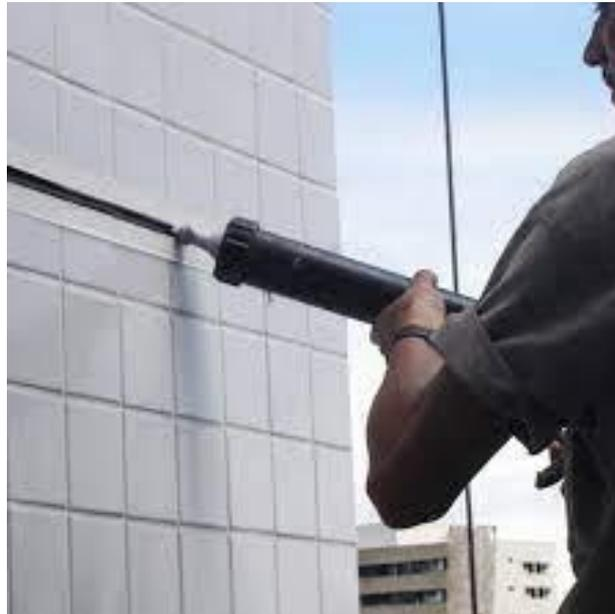
Figura 4: Aplicação de juntas de movimentação
