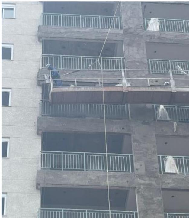
Figura 1 – Execução de fachada convencional com argamassa de revestimento externo (Acervo pessoal, novembro de 2023).
