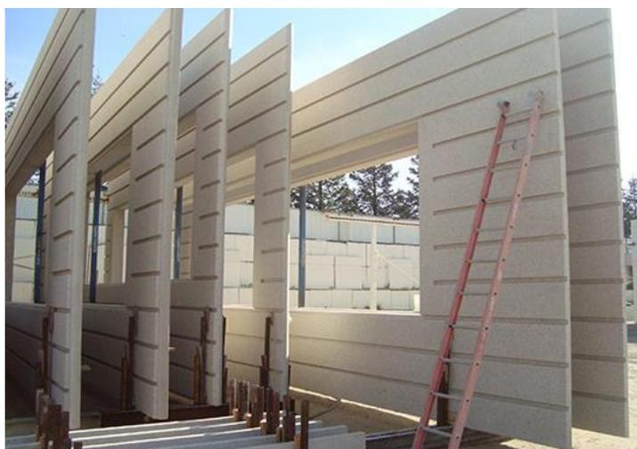
Figura 3: Modelo exemplo fachada pré-fabricada (Banco de imagens Abcic).
