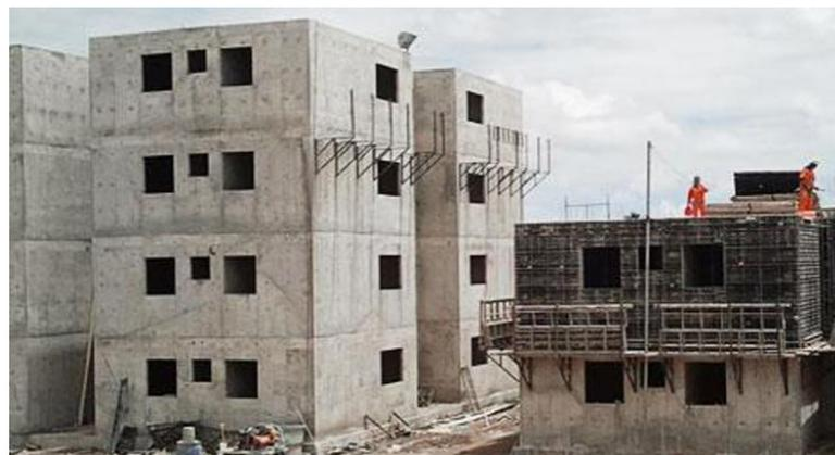
Figura 2: Imagens construção utilizando método de concretagem in loco. (Concreto por Marketing Tecnosil, fevereiro de 2023).
