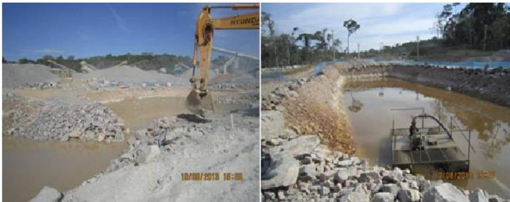
*Figura 2: Ilustração de bacias de decantação em uma obra de hidrelétrica e de um reservatório móvel em substituição ao bate-lastro. Arquivo pessoal.*
