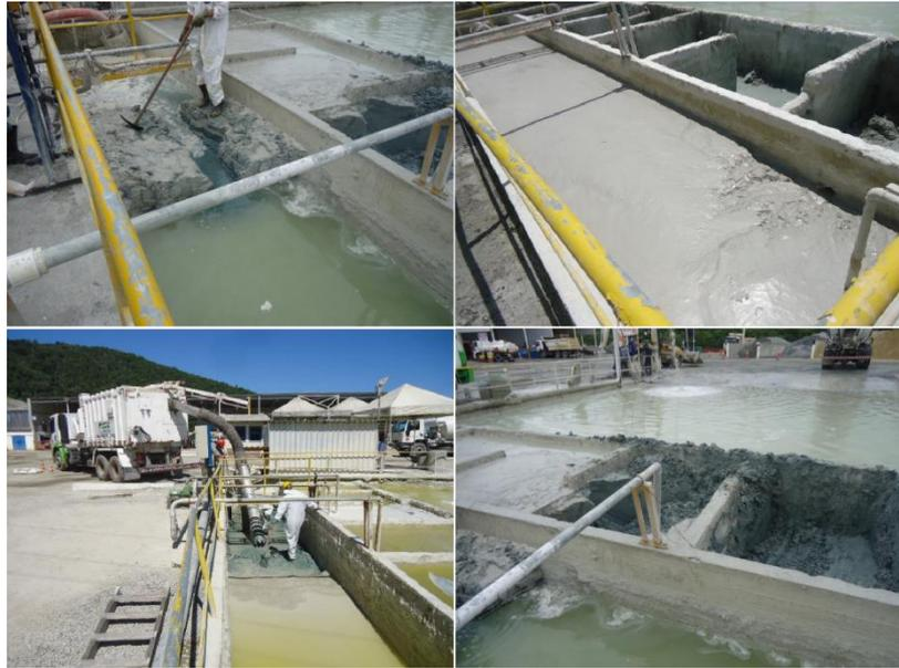
*Figura 1: Ilustração das atividades de manutenção de um bate lastro tradicional com intensa deposição de sólidos. Arquivo pessoal.*
