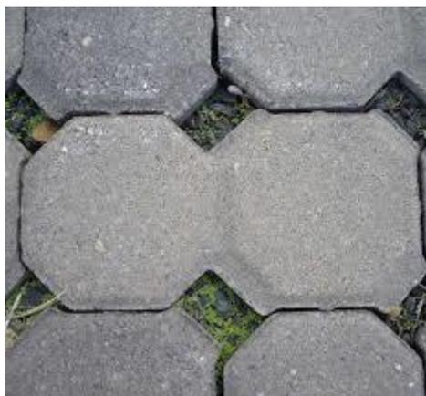
Figura 12 - Crescimento de vegetação em juntas de pavimento permeável (MARCHIONI; SILVA, 2010).
