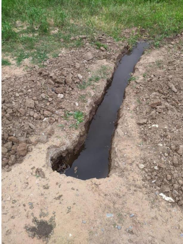
**Figura 12:** Esgoto lançado em valas.
