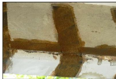
(h) detalhe do lançamento da sílica nas fibras aplicadas na laje.
