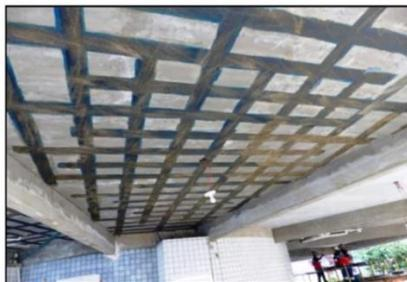
(g) lançamento da sílica nas fibras aplicadas na laje.
