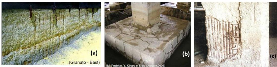
(a) Estrutura de concreto armado deteriorada pelo ataque de sulfatos
