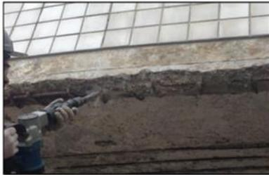
(c) a remoção do concreto desagregado.
