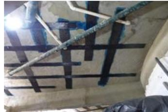
(d) aplicação da fibra de carbono em lajes.
