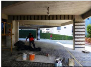
(e) aplicação da fibra de carbono em vigas e pilares.
