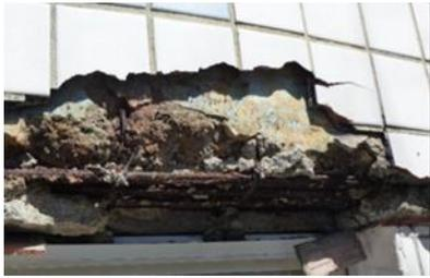
(a) ilustração da remoção do revestimento para análise e identificação das patologias.
