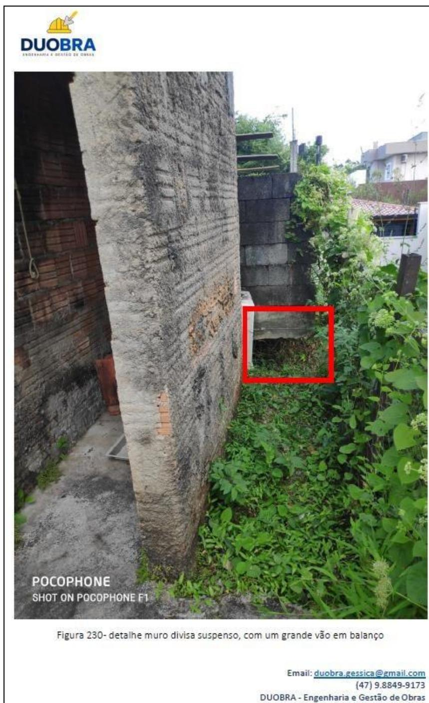
Figura 230- detalhe muro divisa suspenso, com um grande vão em balanço
