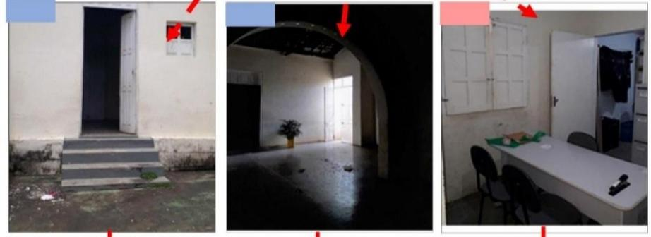
Diagnóstico: no pátio a abertura do vão é inadequada, a soleira tem desnível, falta rampa de acesso, piso e espelho da escada tamanho inadequado, falta sinalização tátil alerta/direcional.
