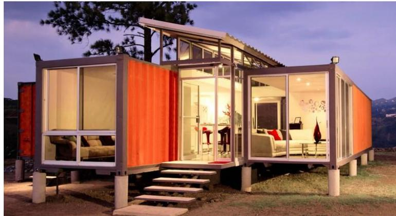
Figura 23: Pilaretes em concreto para fundação dos *containers*.
