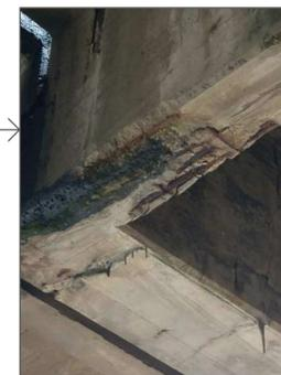
Problema Patológico: Corrosão de Armadura e Eflorescência.
