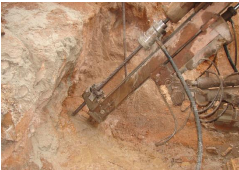
Figura 19. Perfuração tirante auto-injetável.
