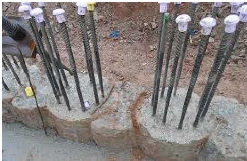
Figura 6. Estacas secantes.
