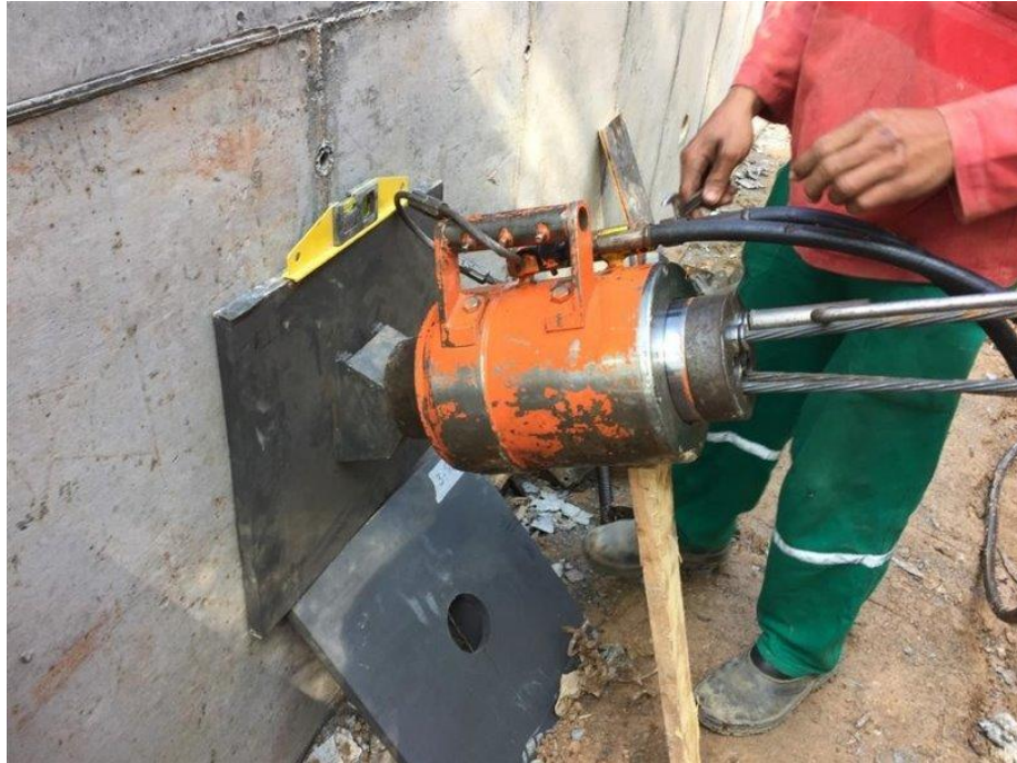
Figura 15. Protensão de tirante com injeção posterior.
