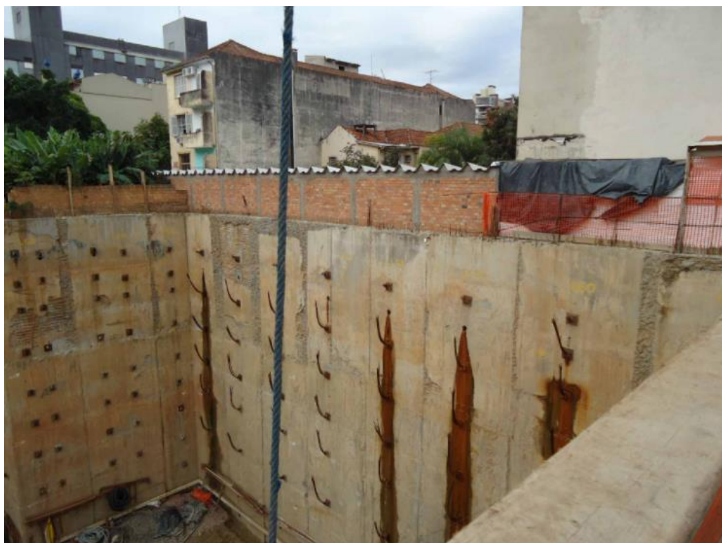
Figura 4. Parede diafragma.
