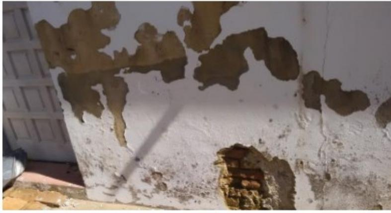
Foto do fundo da escada, recomendado a aplicação do ARMATEC ZN + ARGAMASSA ESTRUTURAL 250
