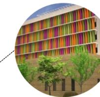
Será utilizado brises móveis com dupla tonalidade na composição das fachadas, com o objetivo de garantir conforto térmico e criar diferentes sensações.
