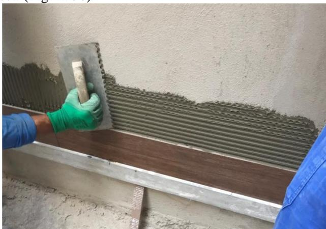
**Figura 38 – Abertura dos cordões de argamassa colante**
