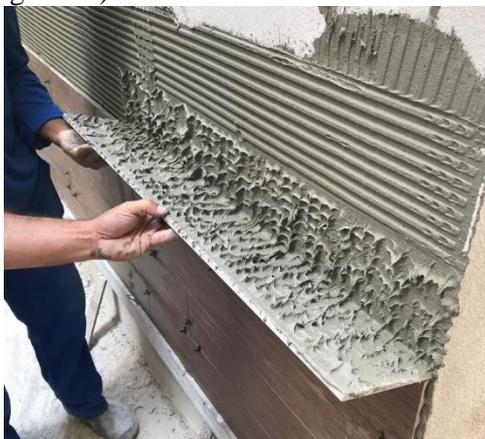
**Figura 42 – Verificação do amassamento dos cordões e do preenchimento do tardo da placa cerâmica**
