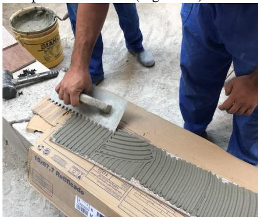
**Figura 39 – Aplicação da argamassa no tardoiz da placa cerâmica**
