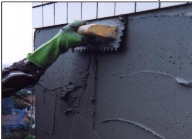
**Figura 37 – Imprimação da camada de regularização**
