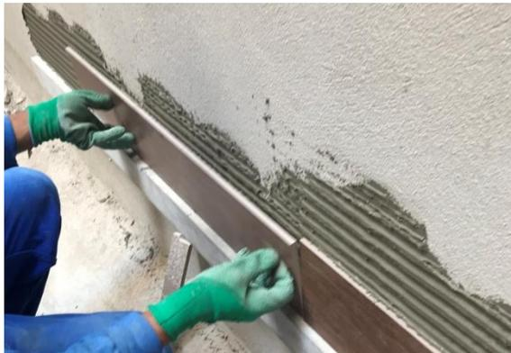
**Figura 40 – Colocação da placa cerâmica fora da posição e assentamento**
