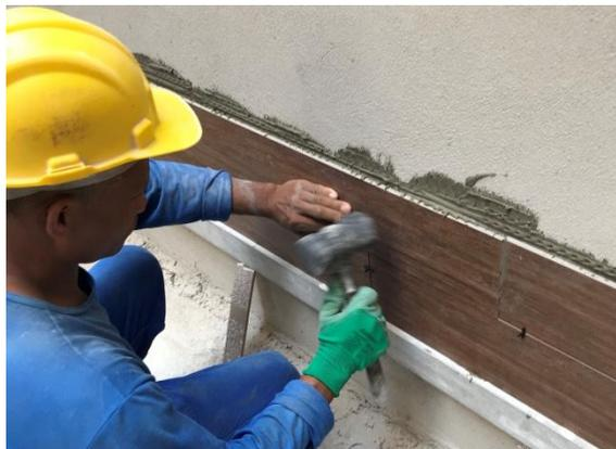
**Figura 41 – Arraste da placa para a posição final e aplicação de golpes de martelo de borracha**
